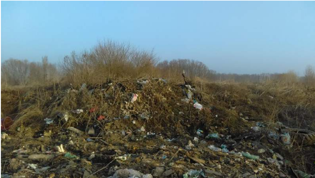
Slika 2.1-1. Postojeće stanje na odlagalištu neopasnog otpada „Stružice“ - sjeverozapadni dio odlagališta, ulaz u odlagalište, slikano s ceste
